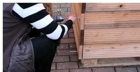
3. Anschrauben der Wände
