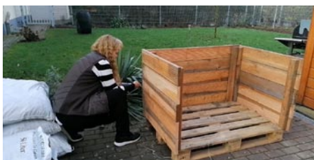
4a. Aufstellen vom zweiten Kopfteil
