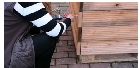
3. Anschrauben der Wände
